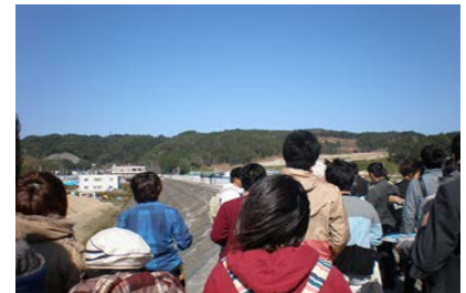
宮古市田老の防潮堤にて
