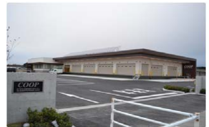
新迫センター外観 太陽光発電パネルが見えます
