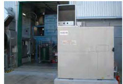
SVOは食用廃食油をろ過した植物性油です。発電機の出力は25kWh、稼働時間は10h。（夜間は除く）
